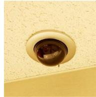
4台のIPカメラは、36倍光学ズーム、水平回転350°、垂直回転-30°-90°のパン、チルト機構搭載
